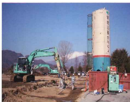
施工状況全景
